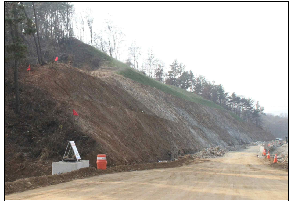
【그림 4】 깎기비탈면 종점부 측면 사진
